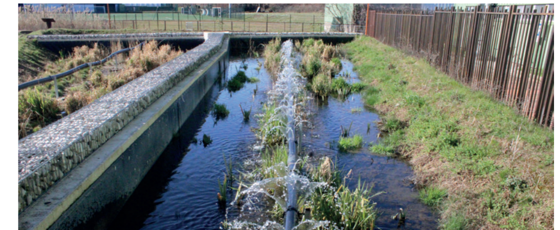
Jardins filtrants – Site des Cressonnières, Saint-Gratien
