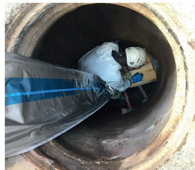
Réhabilitation d'un réseau par chemisage
