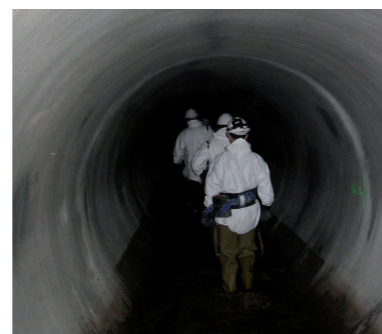
À l'intérieur d'un collecteur visitable
