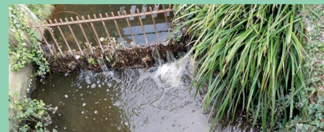
Grille en travers : l'écoulement risque de ne pas se faire correctement
