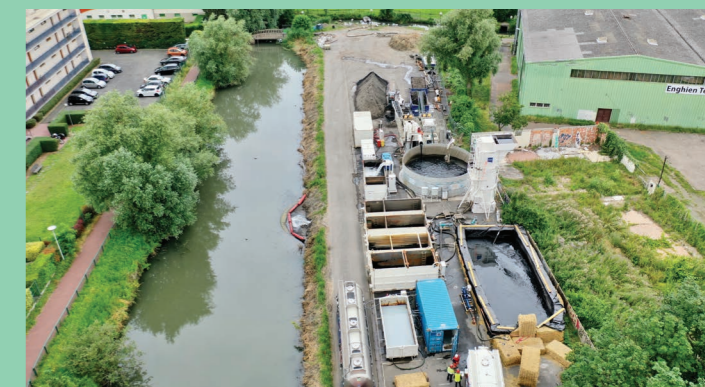
Curage, bassin des Cressonnières, Saint-Gratien
