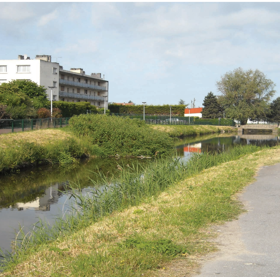
Le bassin des Cressonnières actuellement : un ouvrage situé en amont du lac d'Enghien
