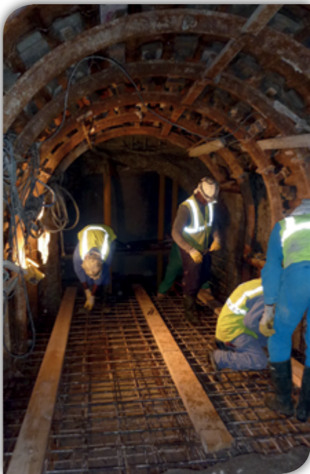
Création d'une galerie pour les eaux usées.
