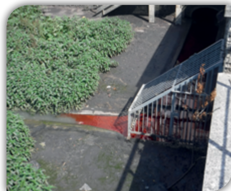
Pollution au fuel rouge sur le bassin de rétention « ZAC de la Jonction » à Montmagny – juillet 2017
