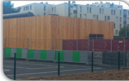
Le local technique est habillé d'un bardage de bois
