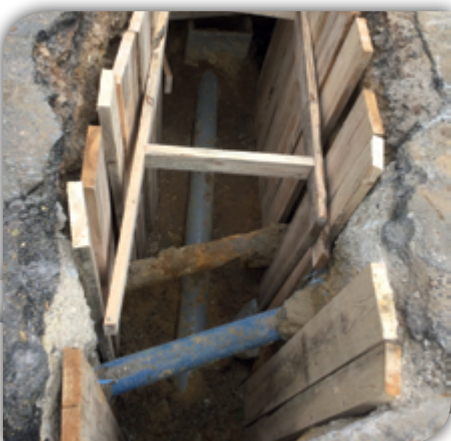
Chantier rue d'Erment
