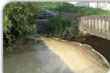
Pollution sur le bassin de rétention des Cressonnières à Saint-Gratien – septembre 2014
