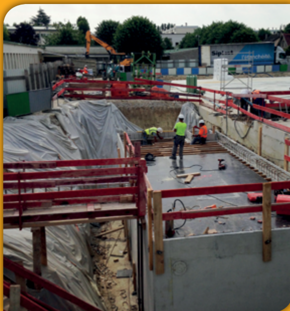
Construction du bassin de récupération d'eau pluviale
