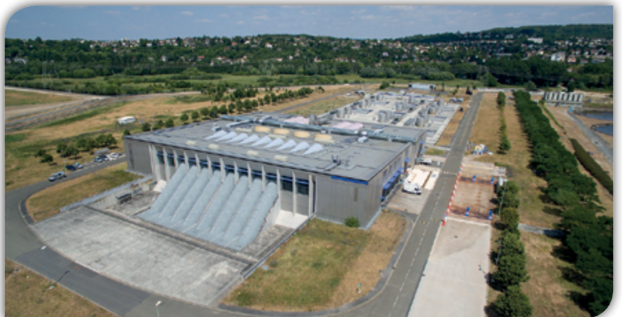
L'usine Seine Aval vue du ciel : une capacité de traitement de 1,5 million de m 3 par jour
