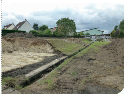
Travaux de terrassement
