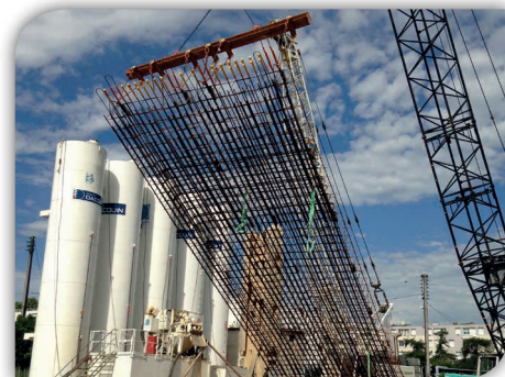
Pose de la cage d'armature en juillet
