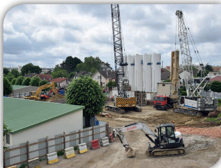
Vue générale du chantier en juin 2016
