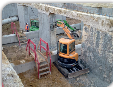
Terrassement en septembre
