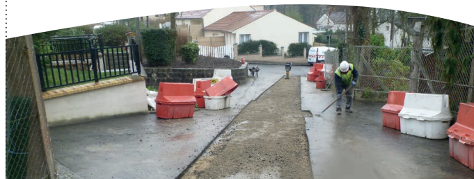
Travaux de remplacement des réseaux d'eau pluviale
