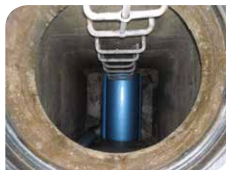
Gaine introduite dans le réseau
