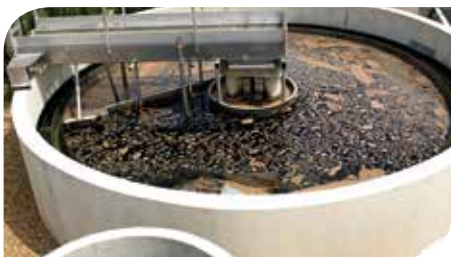
Station d'épuration produisant des déchets solides
