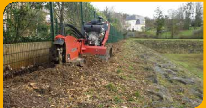
Travaux de plantation de la haie
