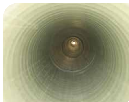
Collecteur après travaux
