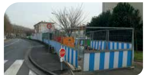
Chantier de réhabilitation sans tranchée à Eaubonne
