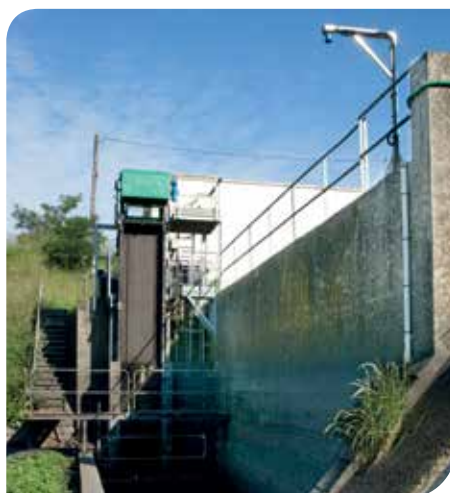
Sonde sur un bassin
