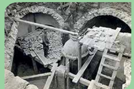
Démolition du raccordement des conduites d'eaux usées au Pont Aqueduc Usine de Colombes - 15 février 1933.
