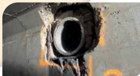
Anomalie détectée dans un collecteur
