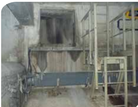
Exemple de bassin unitaire : le bassin des Carreaux
