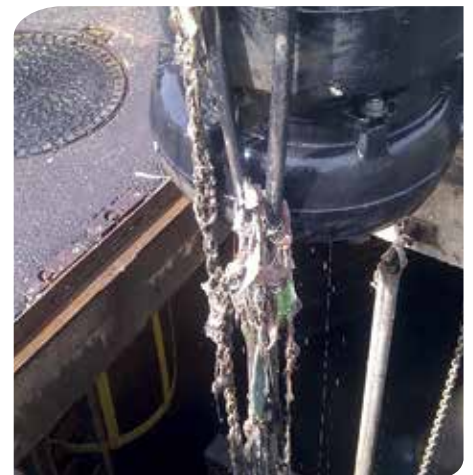
Pompe encrassée par de la filasse de lingettes
