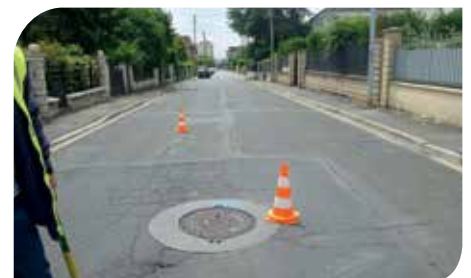
Repérage d'un tampon, rue de la République à Montmorency
