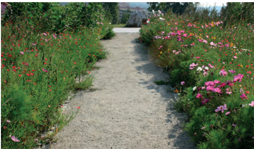
Allée en graviers : l'eau peut s'infiltrer
