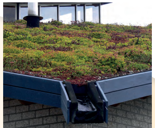
Toiture végétalisée : l'eau de pluie est en partie absorbée par la végétation
