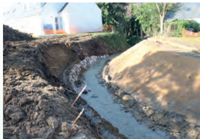
Les travaux de renaturation du ru
