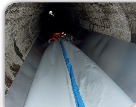
Opération de gainage
