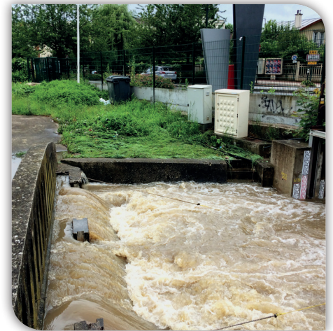
Débit rapide au Bassin des Cressonnières
