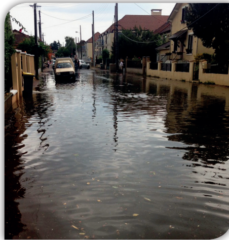
Accumulation d'eau au point bas d'une rue
