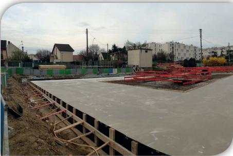
Mars : réalisation de la dalle de couverture
