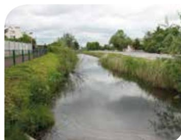
Le bassin des Cressonnières occupe une position stratégique dans le système de protection contre les inondations : il reçoit la majeure partie des eaux pluviales du bassin versant du ru d'Enghien et dirige les eaux vers le Lac Nord, via un bras de liaison. Il a également un rôle de décantation des sables entraînés par ces eaux lors des grosses pluies, protégeant ainsi le lac d'Enghien de la sédimentation et de certaines pollutions.
