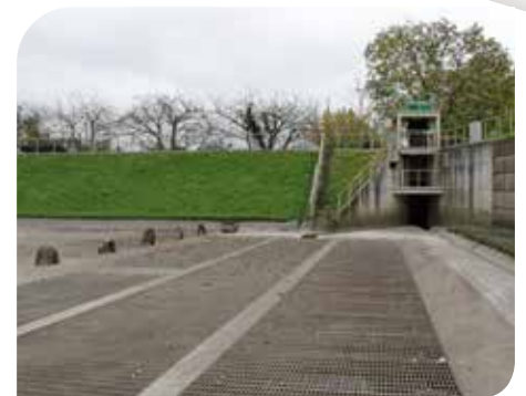
Chambre à sables - Grosly Amont
