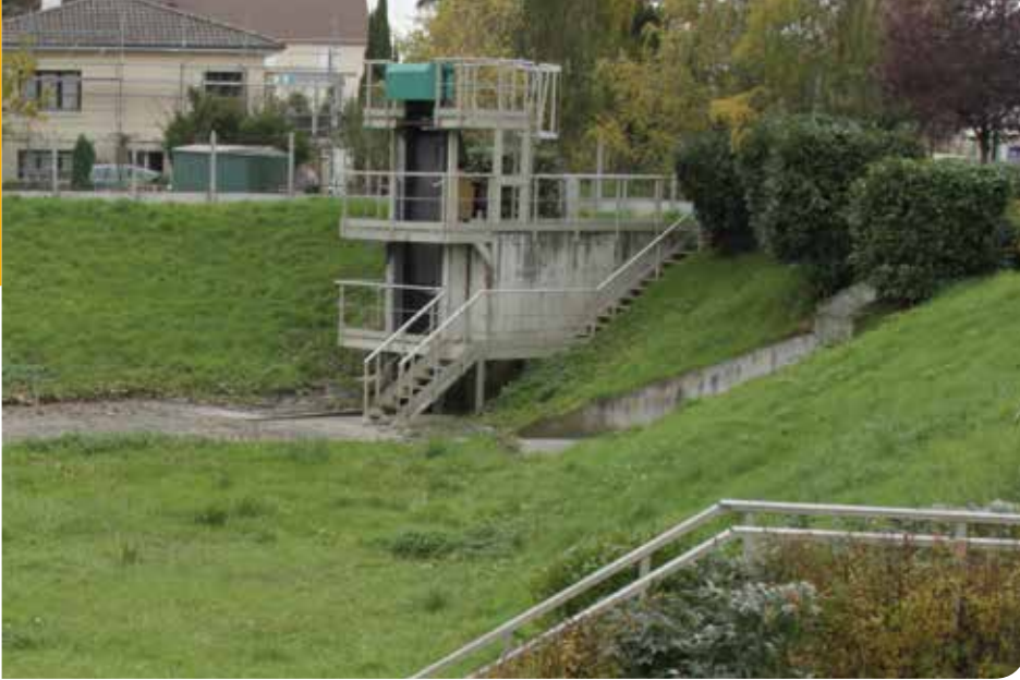
Dégrilleur - Bassin Schweitzer à Soisy-sous-Montmorency
