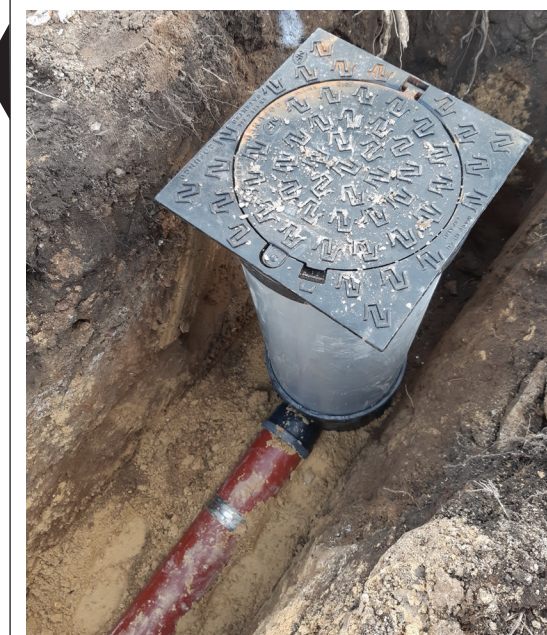
Exemple de branchement en limite de propriété
